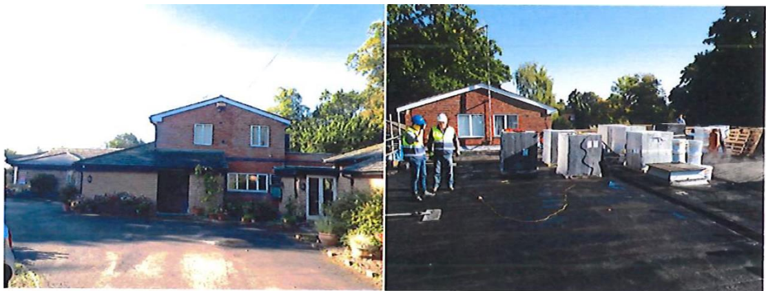
Illustration 1 : Vue du bâtiment/structure du toit plat examiné
