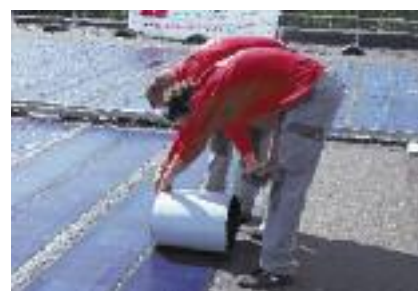
Pose des cellules photovoltaïques
