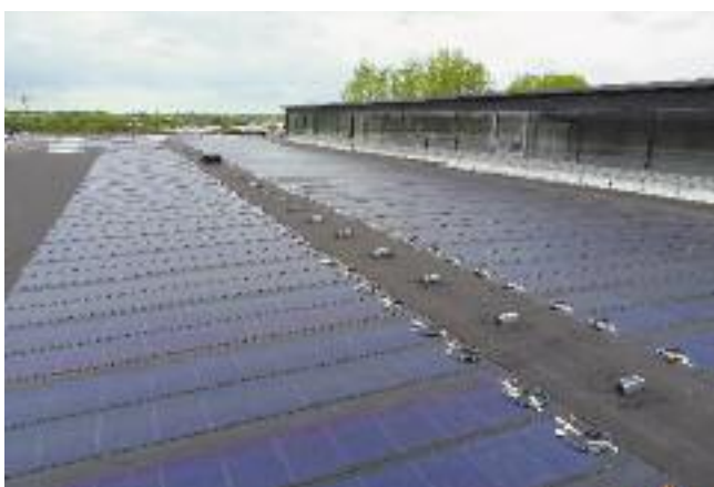
SOPRASOLAR – Bureaux MACIF - Niort, Architecte : JP Renaud-L Maguis
