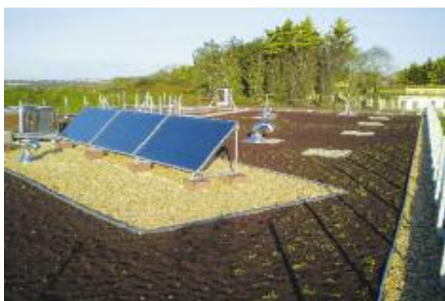
Chenil - Portzic, Architecte : DTM ATLANTIQUE DIVISION COC&FB
