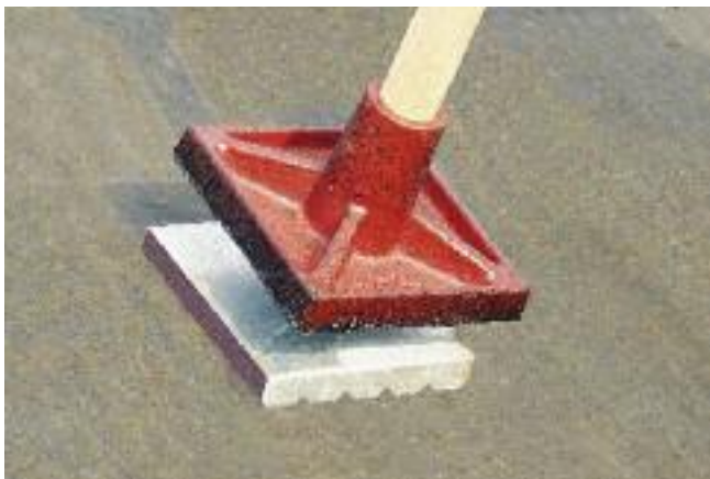
Pose des plaquettes
