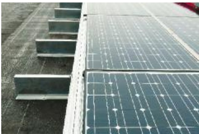
Pose des panneaux sur ossature
