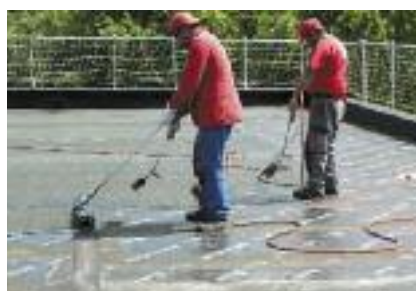
Soudage de la membrane en pleine adhérence
