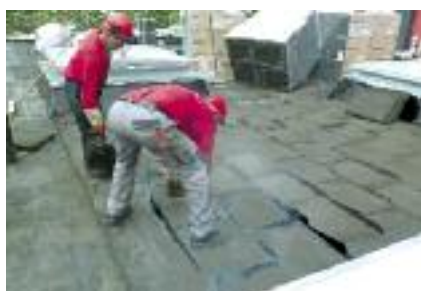
Pose du FOAMGLAS® en pleine adhérence
