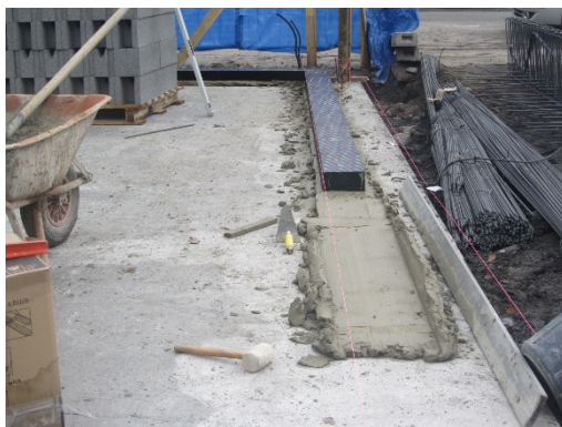
Figure 6 Exemple de pose du PERINSUL HL
