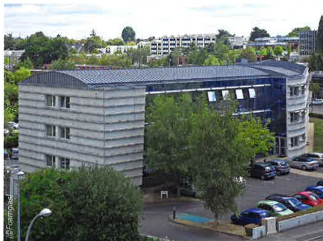
Couverture de l'immeuble de bureaux du Crédit Mutuel à Nantes (44), rénovée en utilisant un support bois avec le système Toiture Compacte VM Zinc. L'air ne peut pas migrer dans la couche isolante grâce à l'étanchéité du Foamglas et du collage des plaques isolantes entre elles. La toiture est compacte, de faible épaisseur, sûre et performante au plan thermique. Maître d'œuvre : Crédit Mutuel Entreprise : Raymond (44)
