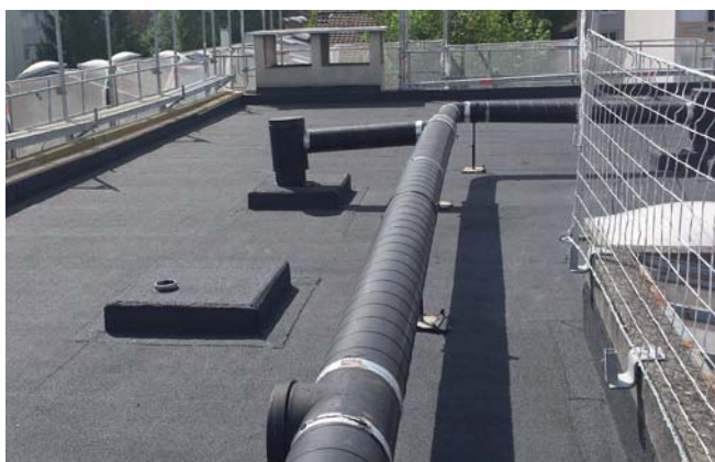
Résidence Paul Vaillant Couturier Malakoff (92) B.E. : VPI Ingenierie (75) Entreprise : Axe Etanchéité (93)
